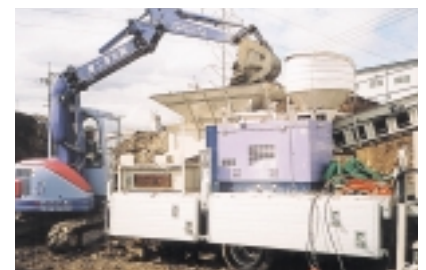
車載式SRプラント 掘削土再生プラントから離れた地域でも掘削土の再生利用をしています。
