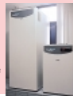
右が燃料電池、左が貯湯槽
