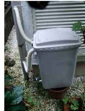
手作りの雨水タンク (材料費約2000円)
